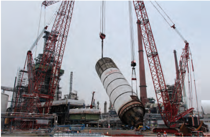
Bild 1: Der mechanische Tausch der Coke-Drums ist eine herausfordernde Aufgabe. (Quelle: MiRO)
