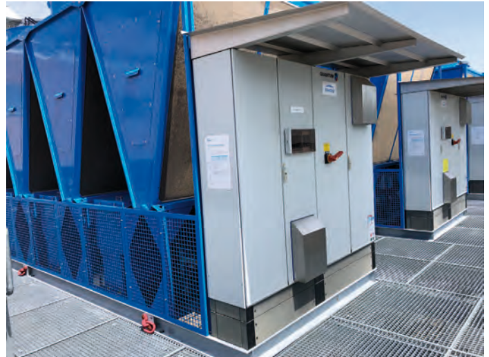
Bild 5: Zum Lieferumfang gehörten außerdem noch die zuvor spezifizierten Feldkomponenten und die notwendigen Systemschalt-schränke (links). Rechts zeigt die Kältemaschine auf dem Dach in Detailansicht
